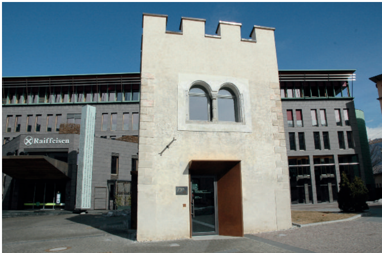
Mit Unterstützung der Raiffeisenkasse restauriert: der ehemalige Pulverturm direkt vor der Hauptstelle des Instituts
